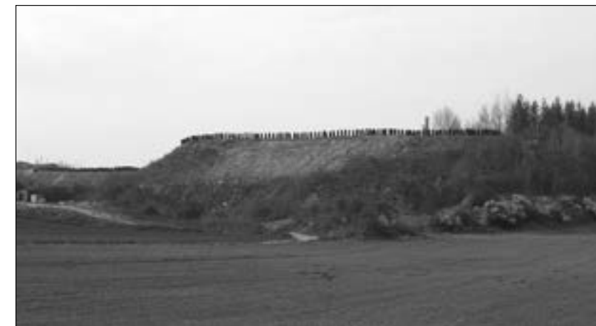
Rys. 3 Wał technologiczny zakładu przeróbki kamienia to pozytywne działanie oddzielające teren zakładu, jednak nieprawidłowe nasadzenia sprawiają, iż ma on negatywny wpływ na krajobraz. (Fot. Bartosz Jawecki) Fig. 3. The positive example of the construction of the shaft separating the plant from the environment. Incorrect plantings cause negative impacts on the landscape
