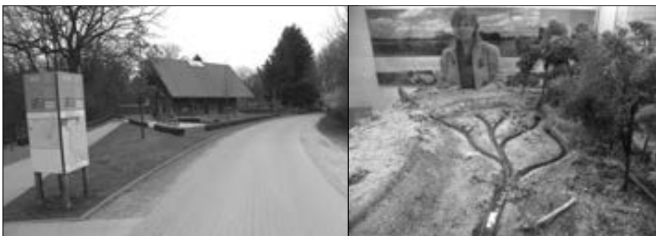
Rys. 5. Budynek Centrum Informacyjnego źródeł rzeki Ems i ścieżki rowerowej wzdłuż rzeki Ems (A) oraz model hydrauliczny źródeł rzeki Ems w Centrum Informacyjnym (B) Fig. 5. Building of Information Centre of the river Ems springs and the bike path along the river Ems (A) and hydraulic model of the river Ems springs in the Information Center (B)
