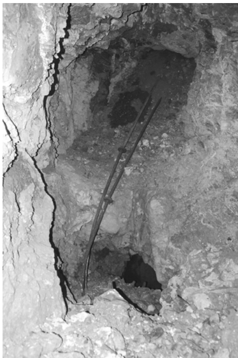
Rys. 3. Częściowo zalane wodą chodniki kopalni „Grochów 1” Fig. 3. The partially flooded headings in the „Grochów 1” mine.
