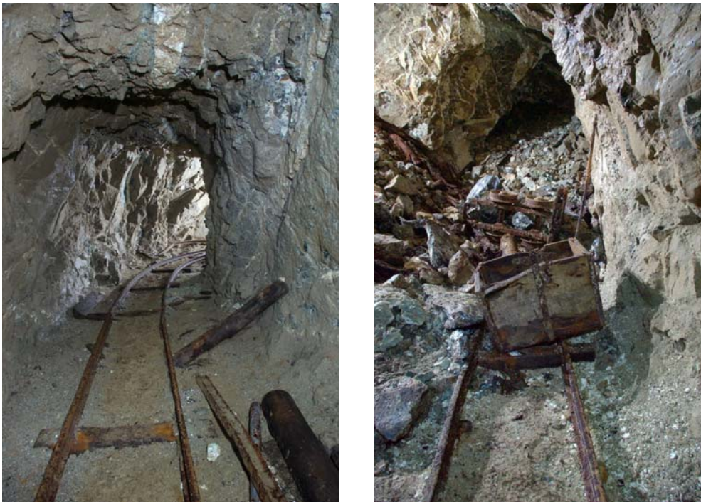
Ryc. 7 i 8. Fragment południowej części chodnika na poz. II, z dobrze zachowanymi torami i zniszczonym wagonikiem (fot. D. Wójcik)
