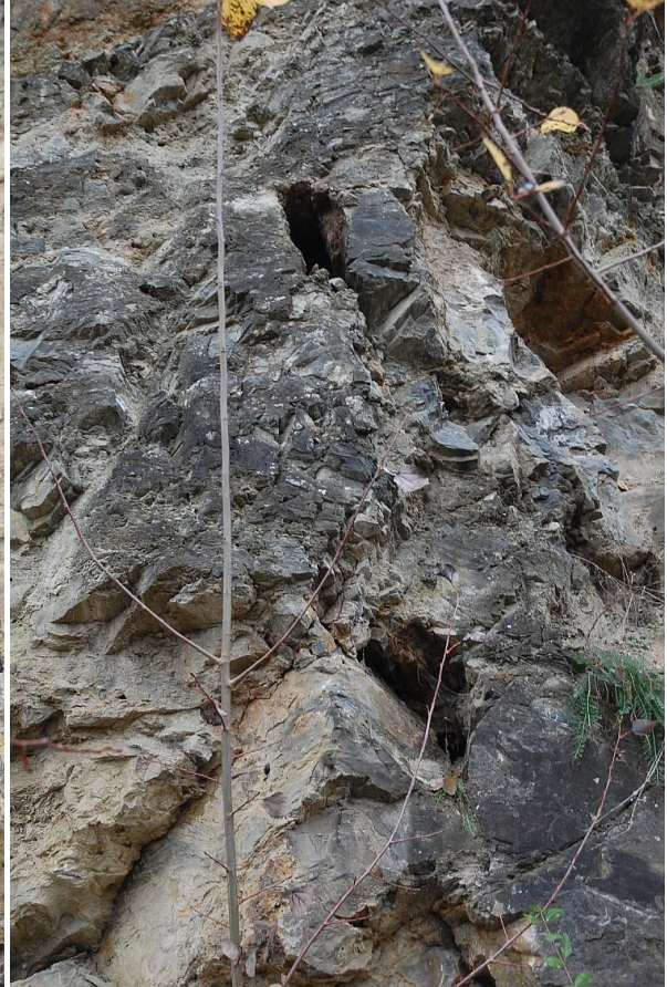
Ryc. 4. Krasowo poszerzone spękania, odstonięte na ścianie po wschodniej stronie wyrobiska (fot. P. Migoń)
