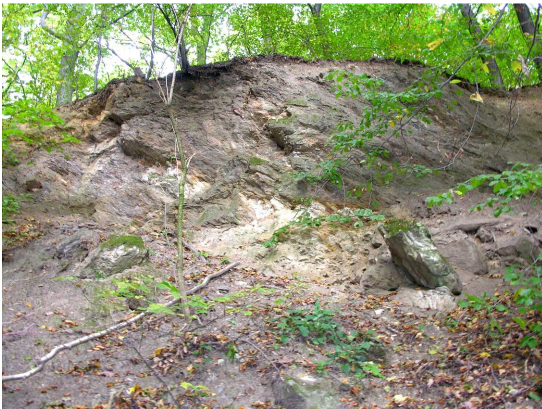
Fot. 3. Skały wapniowo-krzemianowe, środkowa część ściany między wystąpieniami granitu.
