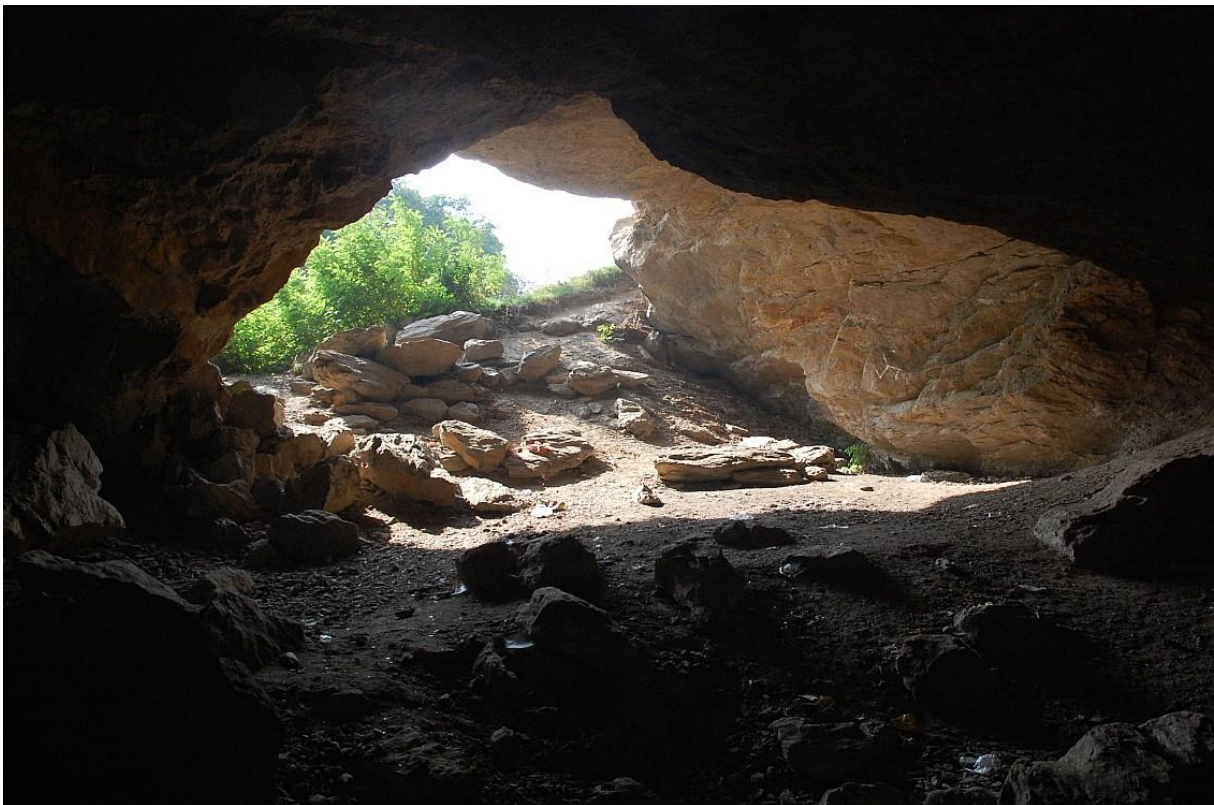
Ryc. 6. Fragment podziemnego wyrobiska w południowej części kamieniołomu, z widocznymi wielkimi blokami oderwanymi ze stropu komory (fot. P. Migoń)
