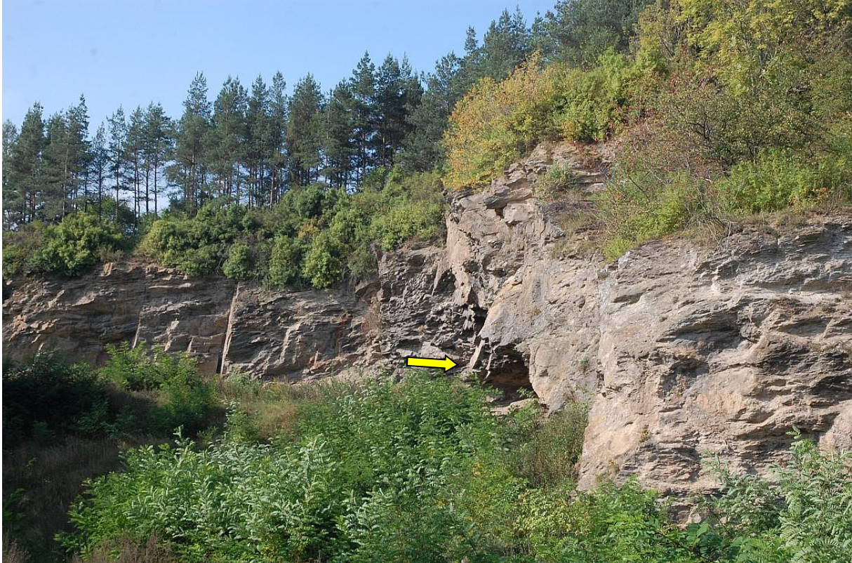
Ryc. 5. W ścianie dawnego kamieniołomu, w wyrobisku południowym, są dobrze widoczne powierzchnie foliacji oraz regularne pionowe spękania. Po prawej stronie (strzałka) znajduje się wejście do obszernej podziemnej komory wyrobiska południowego (fot. P. Migoń)
