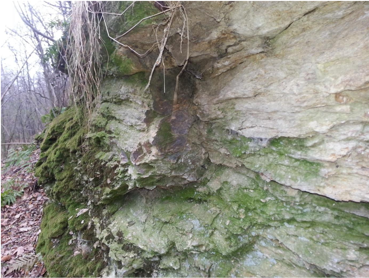
Fig. 2. Fotografia ilustrująca struktury deformacyjne widoczne w kamieniołomie.
