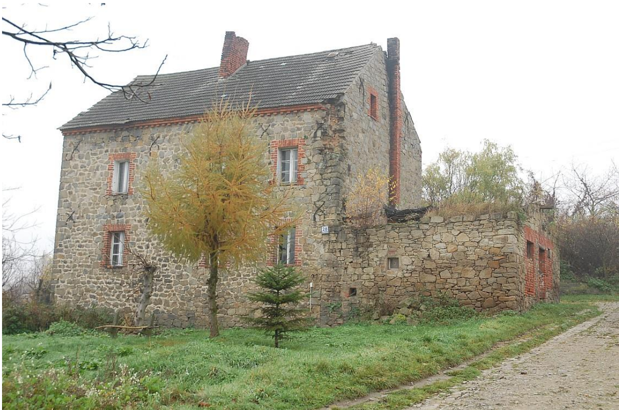
Ryc. 6. Zbudowany w granitu dom przy drodze do kamieniołomu pod Koziniec (fot. P. Migoń)
