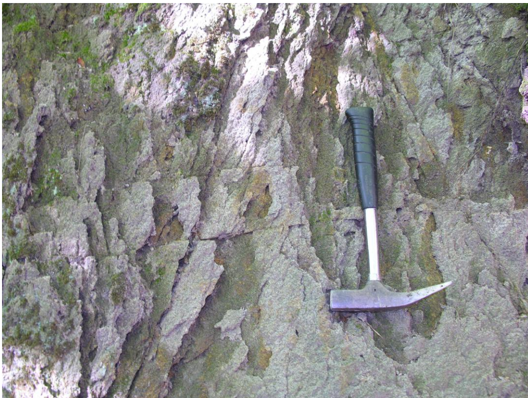
Fot. 6. Zwiędnięta powierzchnia ściany tonalitowej z widocznymi spękaniami.
