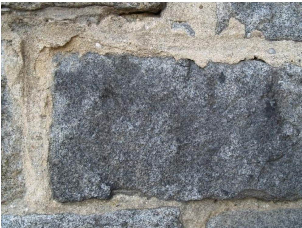
Rysunek 5. Łupany granit strzeleński w murze kościoła w Jegłowej.
