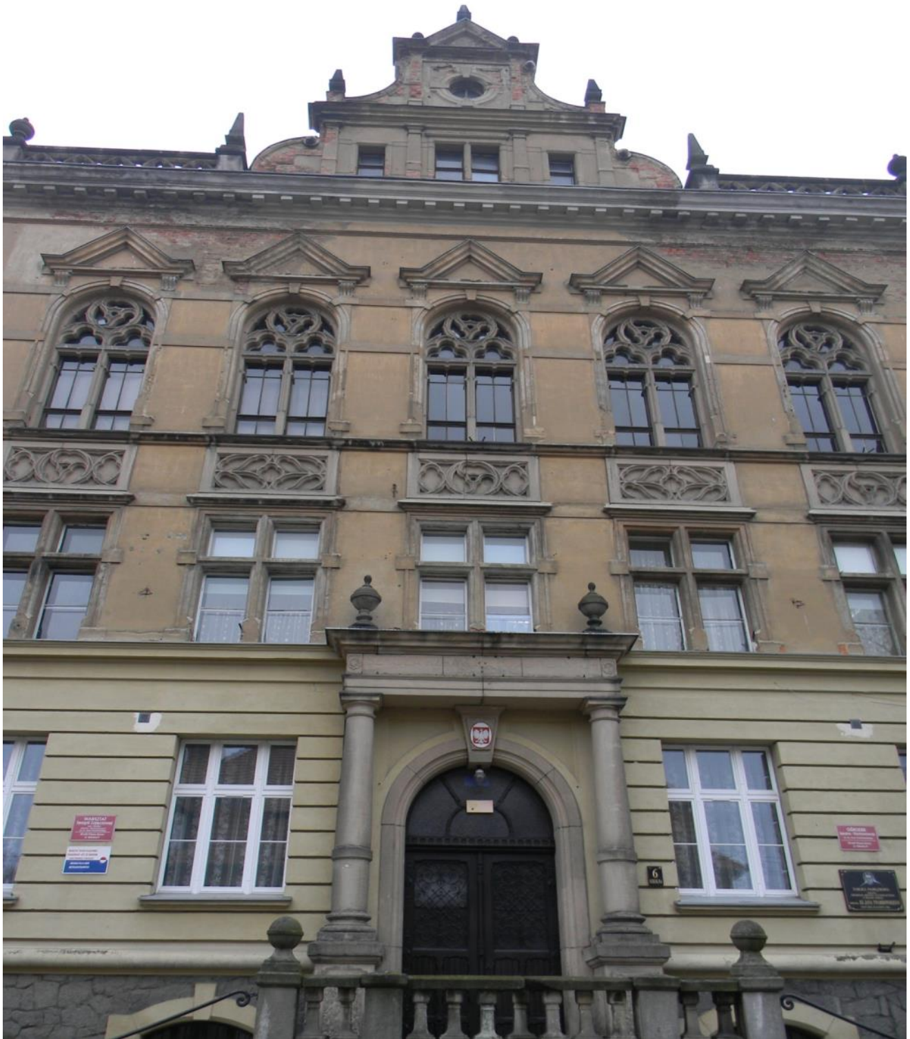
Załącznik 3B. Geostanowisko nr 190 - Ośrodek szkolno-wychowawczy (gimnazjum), widok od frontu; widoczne kolumny, balustrady, gzymsy i okiennice wykonane z piaskowca dolnośląskiego; fundamenty i murki z granodiorytu z Koźmina; oraz schody z granitu strzegomskiego.
